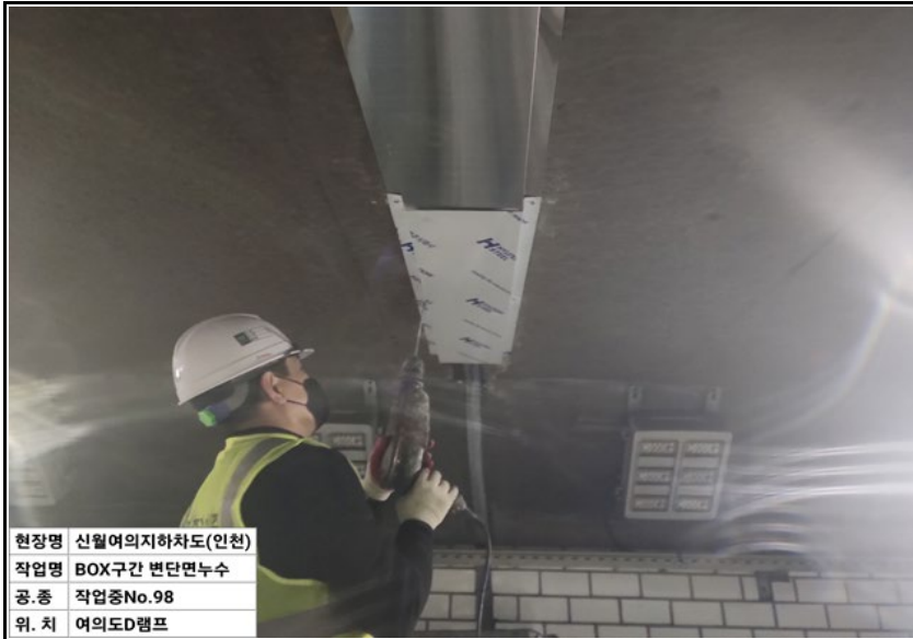
현장명 신월여의지하차도(인천) 작업명 BOX구간 변단면누수 공.종 작업전No.98 위.치 여의도D램프
