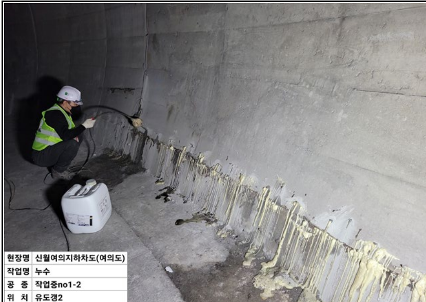
현장명 신월여의지하차도(여의도) 작업명 누수 공 종 작업전no1-2 위 치 유도갱2
