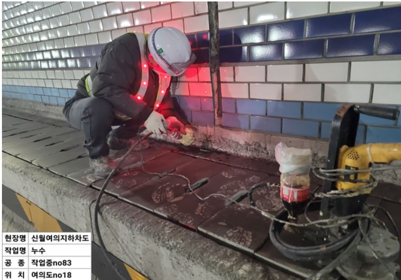
현장명 신월여의지하차도 작업명 누수 공 종 작업전no83 위 치 여의도no18
